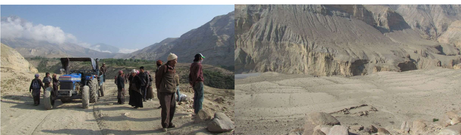
Hier wird die Apfelplantage entstehen
