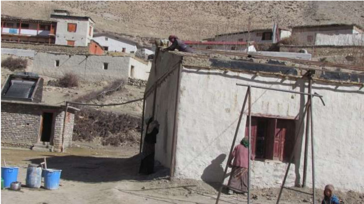
Bau des neuen Daches
