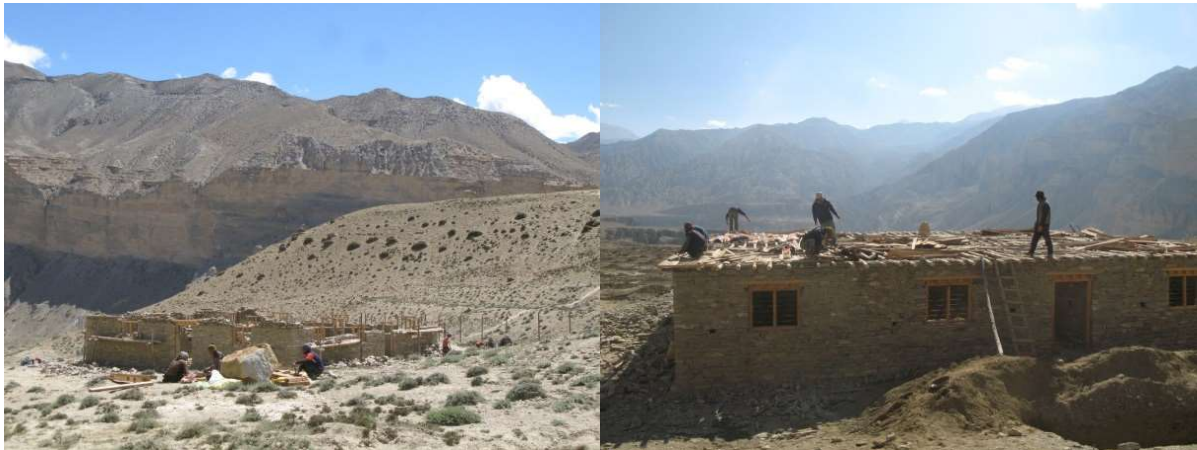
Bau der Unterkunft
