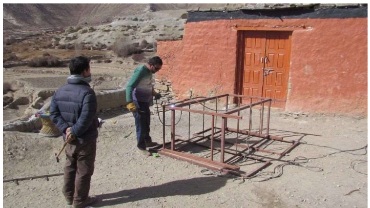
Hier werden die neuen Betten montiert
